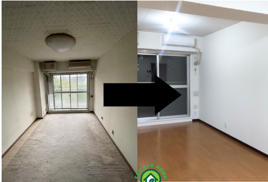
壁・天井クロス貼り替え、床カーペット剥し、CF貼り替え、クリーニング
