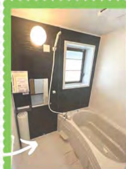
浴室入れ替え工事
